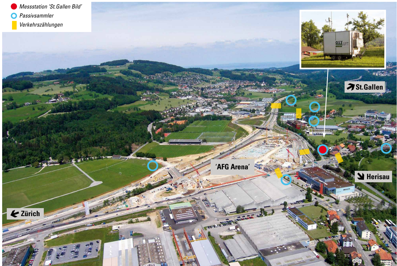
'St. Gallen West' mit einem Teil der Messnetze während der Bauphase.
