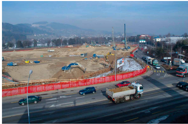
Die Aushubarbeiten und Materialtransporte belasten die Luftqualität am stärksten.
