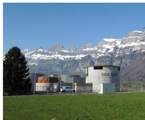
Abb. 1: Standort Flums ARA
