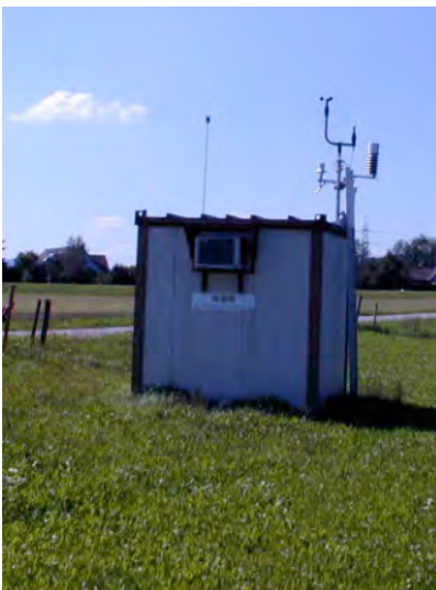
Überwachungsstation KVA Weinfeld
