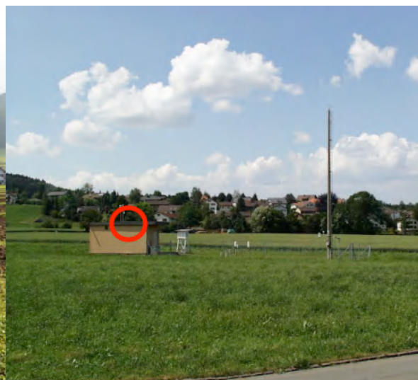
Blick Richtung NW
