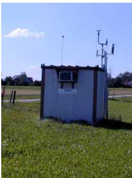
Überwachungsstation KVA Weinfeld
